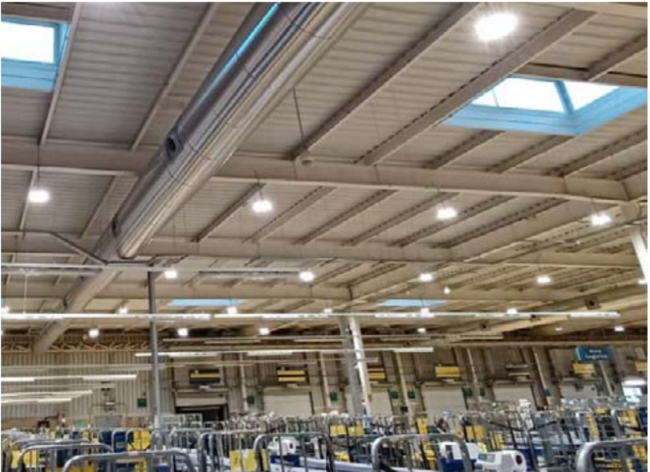
Central de Correos de Valladolid
